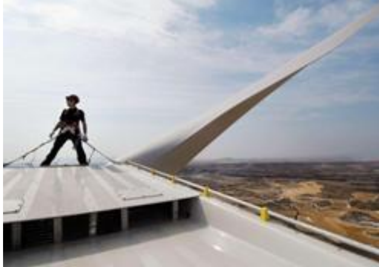
Abbildung 11-1: Arbeiten auf dem Maschinenhaus
