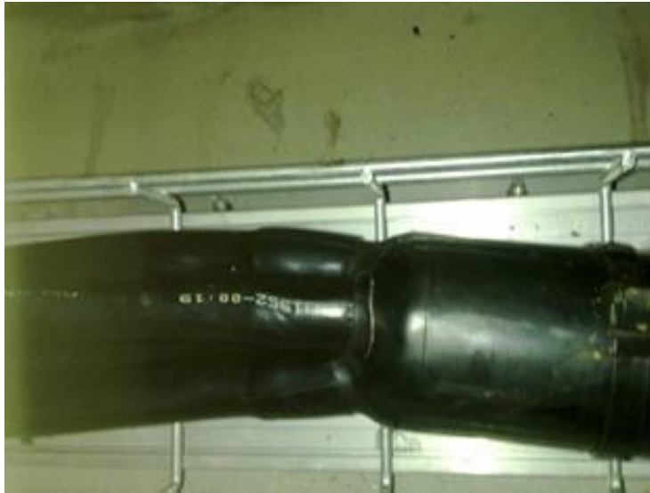
Abbildung 7-1: Risse im Schrumpfschlauch des Mittelspannungskabels.
