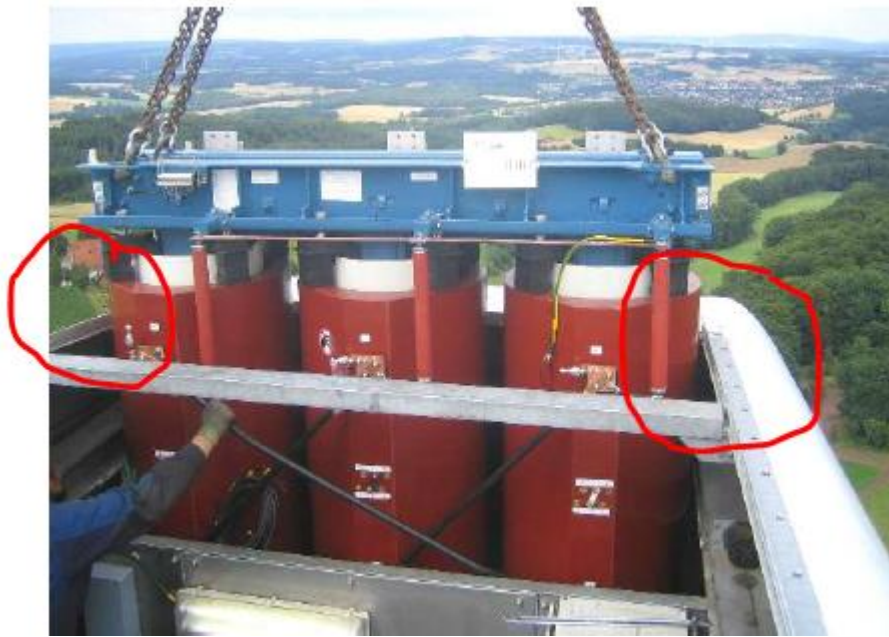
Abbildung 19-1: Führen des Transformators in das Maschinenhaus
